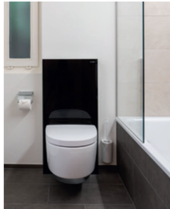
EFTER Vägghängd duschoalett med Geberit Monolith
