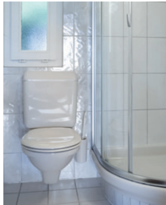
FÖRE Toalett med utanpåliggande cistern
